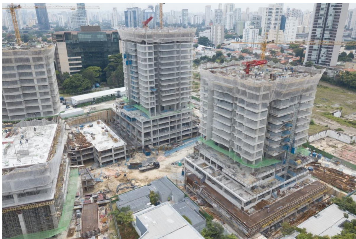
Canteiro de obras do empreendimento O Parque. Foto: Paulo Brenta
